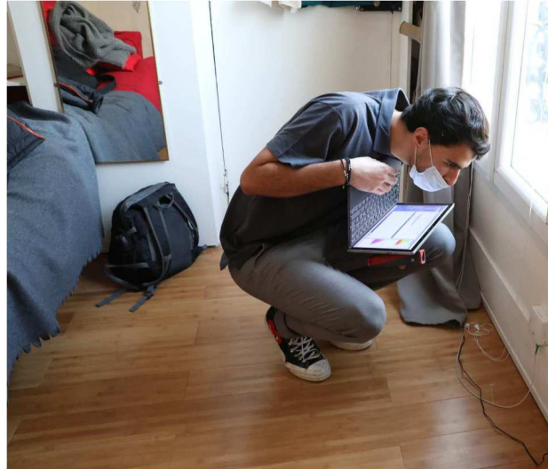
Un professionnel est venu diagnostiquer le studio de Victoire, situé dans le IV e arrondissement de Paris. Résultat : de gros manquements concernant l'isolation et la ventilation.
